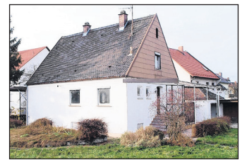
Nach 55 Jahren ausgesiedelt: Ende 2008 wurde das „Energiefressende“ und nach heutigem Kenntnisstand für die Umwelt als nicht vertretbar eingestufte Einfamilienhaus in Dachau-Ost abgerissen.
